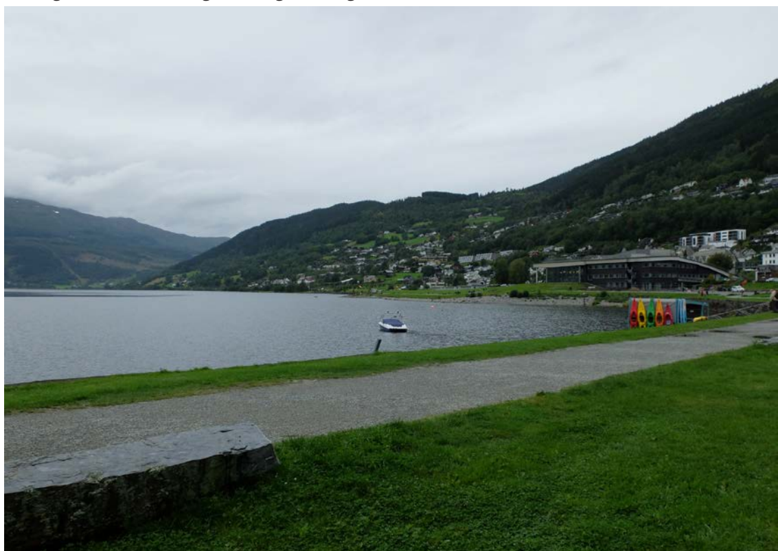
Figur 5.3. Flomsikringmur langs Prestegardslandet, 2024
